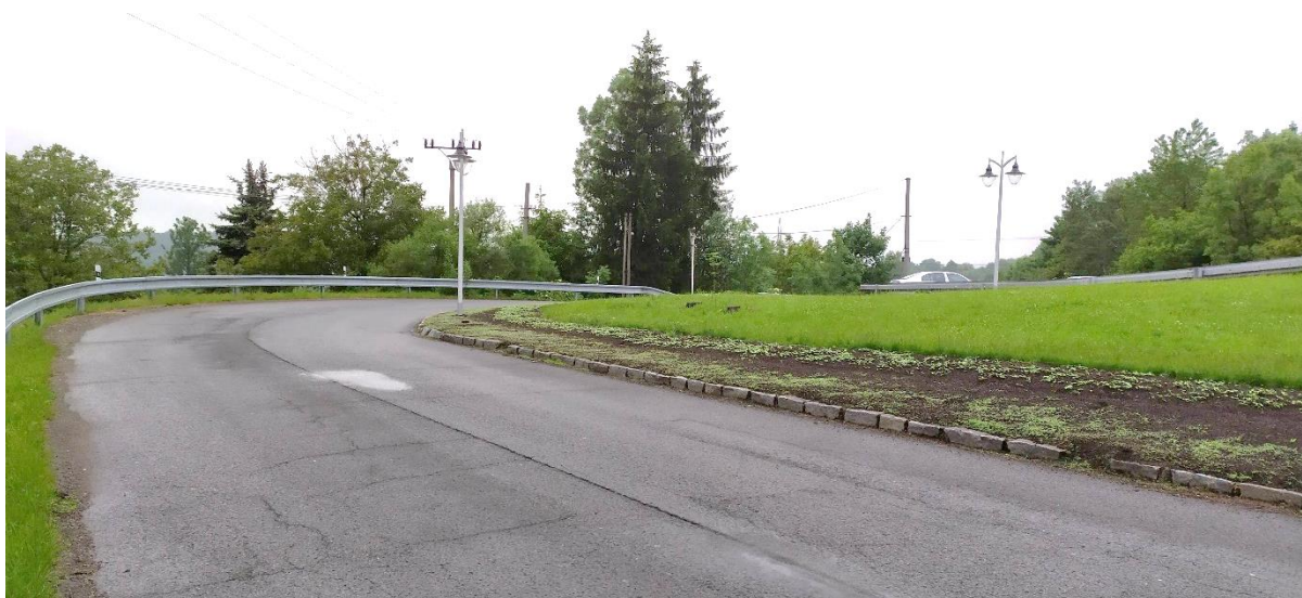
Severní část řešeného území. Místní komunikace se v křižovatce napojuje na silnici II. třídy č. 474. Vnitřní oblouk trávnickové plochy bývá využíván k sezónním instalacím (dožínky, vánoční výzdoba apod.).
