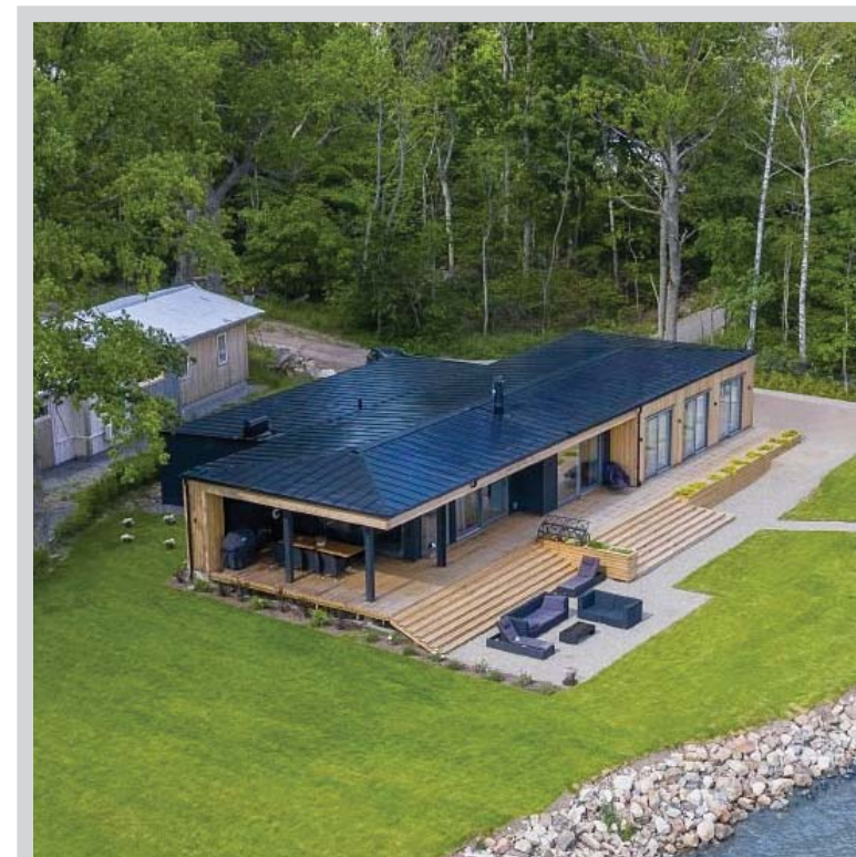
FVE střešní plášť
