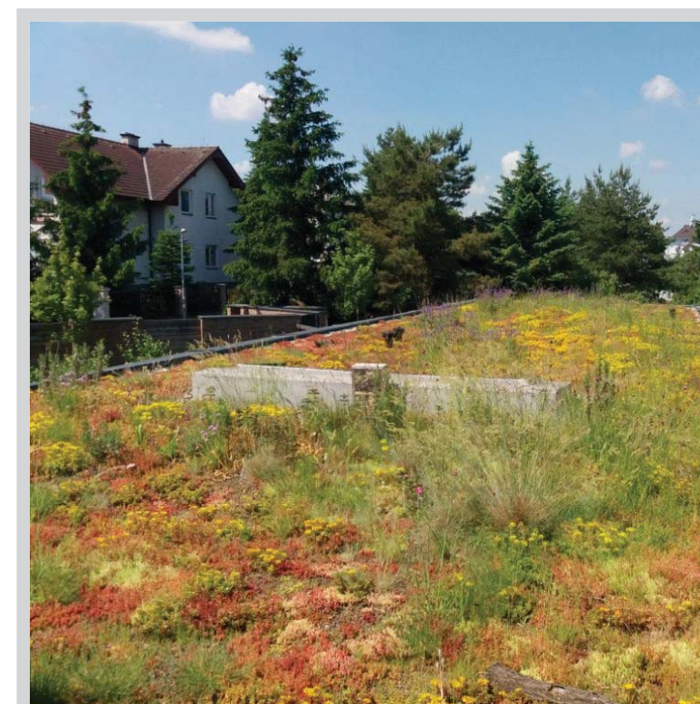
Extenzivní pobytová střecha
